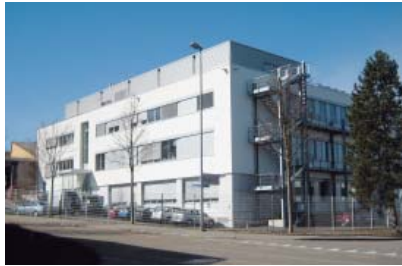
Merck & Cie Laborgebäude C, Schaffhausen, Schweiz
