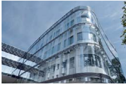
IST Austria Life Science Facilities, Klosterneuburg, Austria
